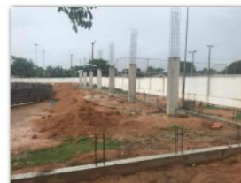
Pilares em concreto armado
