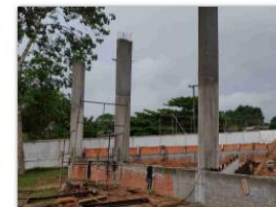
Pilares em concreto armado
