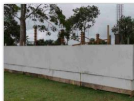
Tapume para fechamento do canteiro de obra
