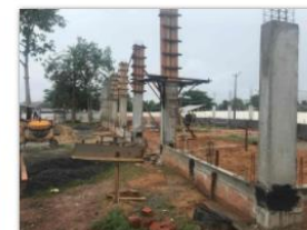
Pilares em concreto armado
