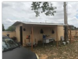
Barracão de obras
