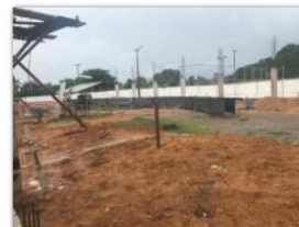
Pilares em concreto armado
