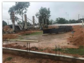
Pilares em concreto armado
