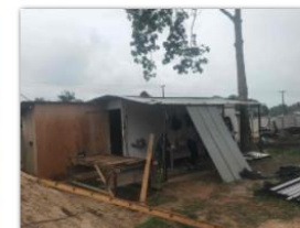
Barracão de obra
